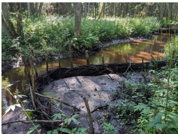
Joonis 1. Näide vitspunutistest jõesängis.
